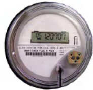
電気メーター
